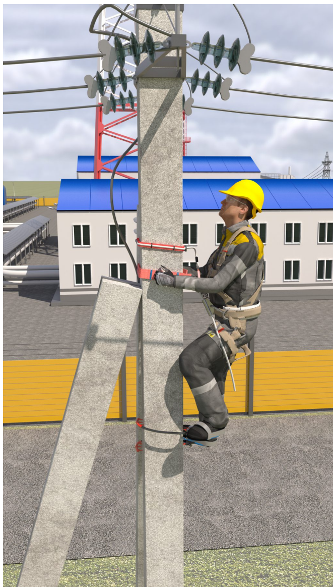
ПОДЪЕМ НА ЖБ ОПОРЫ И РАБОТА НА НИХ
