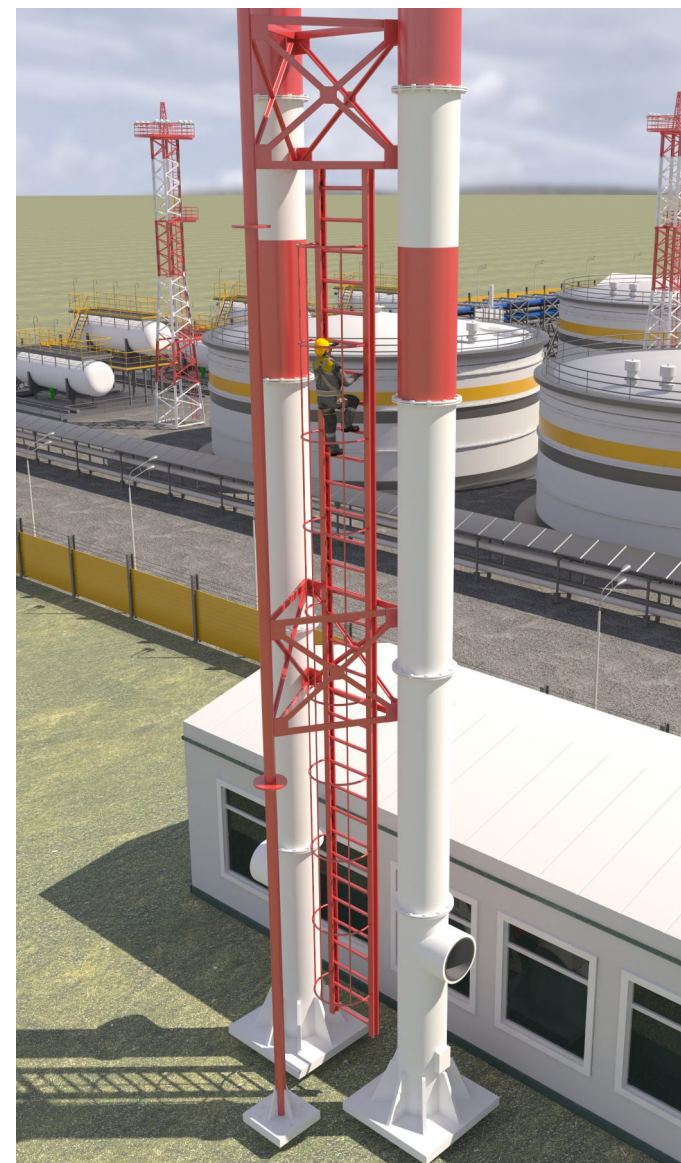
ПОДЪЕМ НА ВЫСОТУ БОЛЕЕ 5 М, ИЛИ СПУСК С ВЫСОТЫ БОЛЕЕ 5 М ПО СТАЦИОНАРНОЙ ЛЕСТНИЦЕ (В Т.Ч. ТОННЕЛЬНОГО ТИПА), УГОЛ НАКЛОНА КОТОРОЙ К ГОРИЗОНТАЛЬНОЙ ПОВЕРХНОСТИ СОСТАВЛЯЕМ БОЛЕЕ 75°
