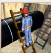
ИСПОЛЬЗОВАНИЕ НЕИСПРАВНЫХ ЛЕСТНИЦ И МОНТАЖНЫХ ПОЯСОВ
