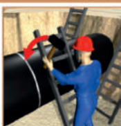
СБОРКА СВАРНЫХ СТЫКОВ, ГИБКА КРОМОК УДАРАМИ КУВАЛДЫ
