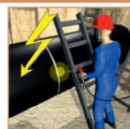
СВАРочНЫЕ РАБОТЫ В ГРОЗУ
