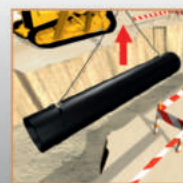
ПОДЪЕМ ТРУБОПРОВОДА С ПРИМЕНЕНИЕМ СТРОП-УДАВОК
